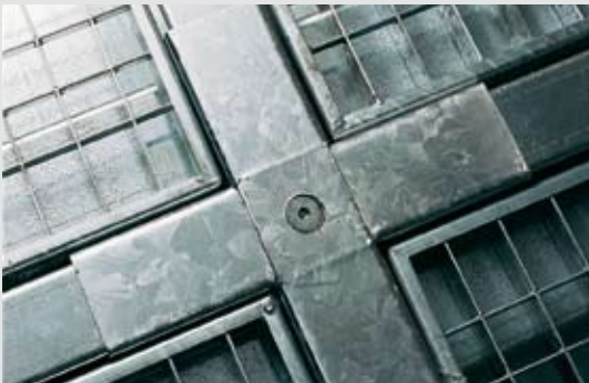
Kreuzverbinder fixieren die Flachwannen an den Knotenpunkten
